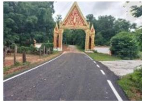
โครงการปรับปรุงผิวแอสฟัลต์ติกส์คอนกรีตบ้านดอนเค็ง หมู่ที่ 9 บริเวณถนนสายทางไปวัดบ้านดอนเค็ง
